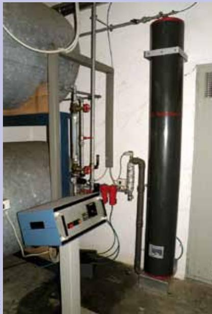
**Stickstoffgenerator: rechts das Membranmodul, im Vordergrund die Steuereinheit und hinten die Drucktanks.**
